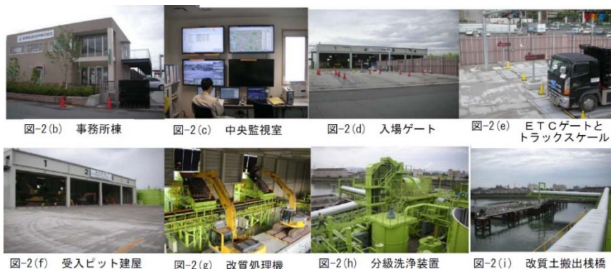
図-2(f) 受入ピット建屋 図-2(g) 改質処理機 図-2(h) 分級洗浄装置 図-2(i) 改質土搬出栈橋
