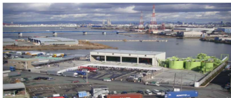
図-2(a) 再資源化処理施設の全景（事業開始当初）
