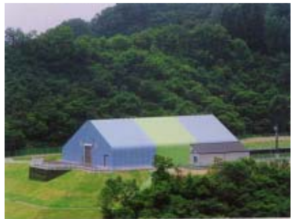
写真㊦ 最終処分場で現在稼働している埋立部分。この地域は良質米の産地であると同時に、全国有数の豪雪地帯である。雨水や融雪水が流入するのを防ぐためビニール製屋根が設置されている。
