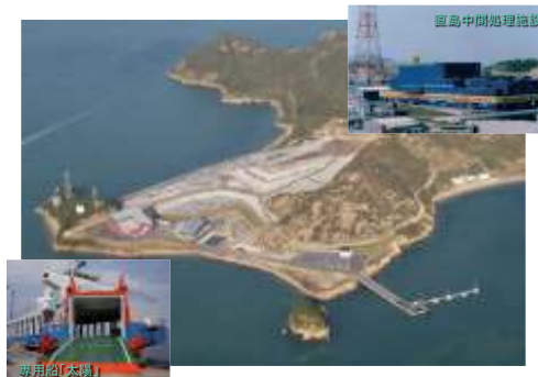
操業診断・管理システム(写真:豊島事業場)
