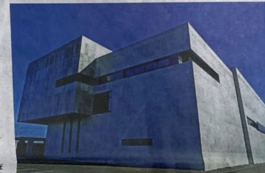
2024年10月に開業したデータセンター（京セラコミュニケーションシステム提供）
