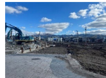
輪島市での公費解体
