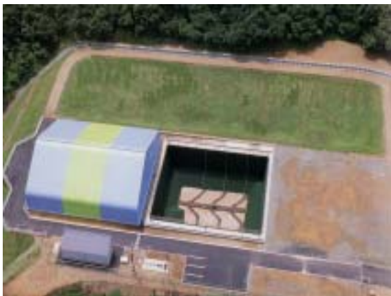
写真㊤ 最終処分場を上空から見ると、現在は左下の屋根がかかっている貯留槽部分で埋立作業が行われ、もう一つの貯留槽が準備されていることが分かる。
